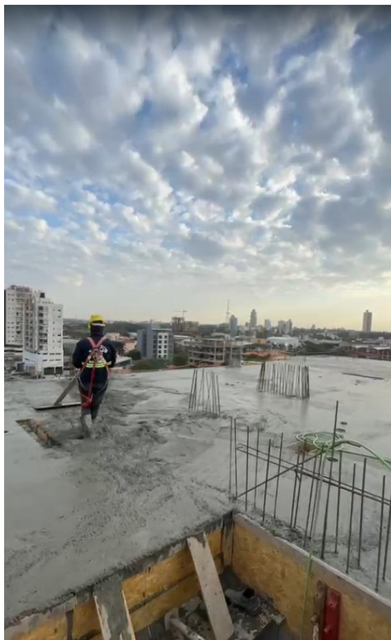
Cargamento Losa N7 – Cargamento de pilares N7 – N8 - Cargamento de escalera PB – N1
