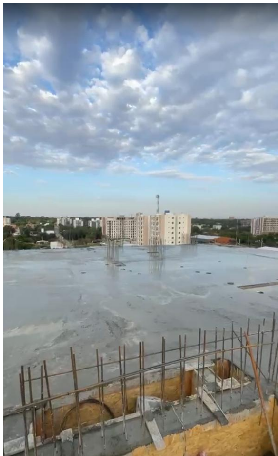
Cargamento Losa N7 – Cargamento de pilares N7 – N8 - Cargamento de escalera PB – N1
