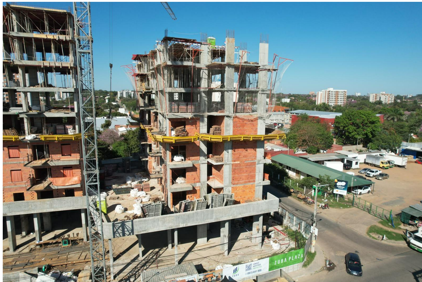
Avance de mamposterías de N1 a N4
